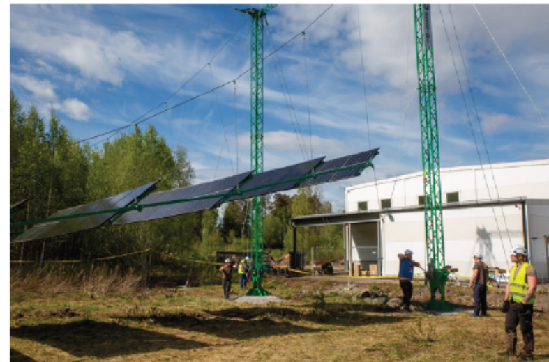
Här hissar panelerna upp sex meter i luften.
