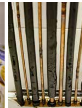
Isolera rör.
