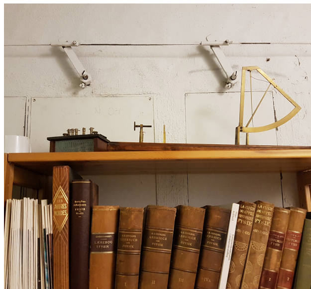
De gamla spjällen motoriserades vid ombyggnad av kalorifersystemet 100 år efter skolan byggdes.
