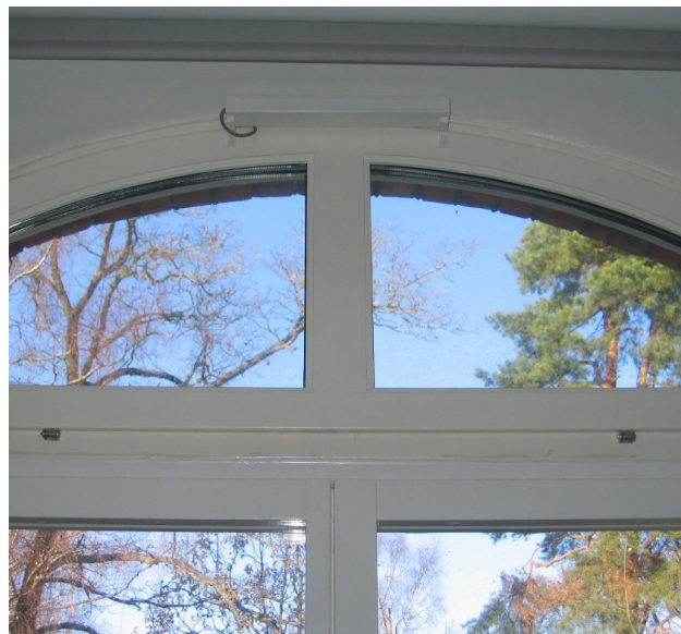
I bilden syns ett exempel på hur gamla vädringsfönster kan kompletteras med motor.
