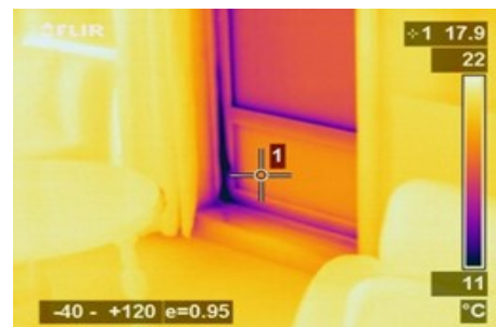
Värmefotografering för att hitta energitjuvar
